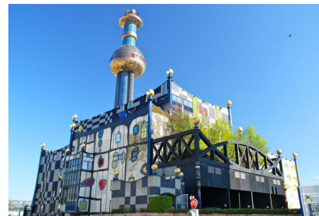
Рис. 4. Мусоросжигательный завод Шпиттелау, г. Вена
